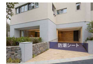
防潮シートを設置したマンション
