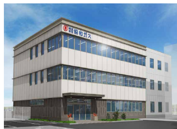
『ZEB』を達成した事務所 「協和ガス 本社屋棟」 (沖縄県)
