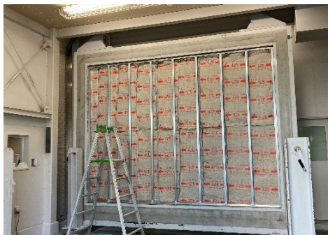
写真2 試験体施工時 (スタッド・ロックウール)
