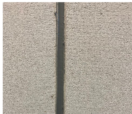
写真 3 シーリング充填部
