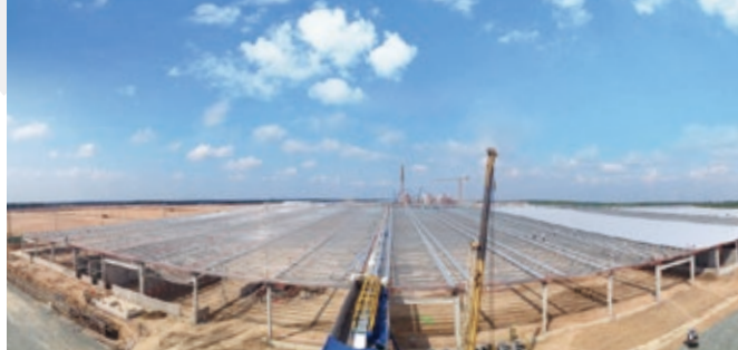
LIXIL GLOBAL VIETNAM FACTORY(面積71,995m 2 、平成25年9月竣工予定)
