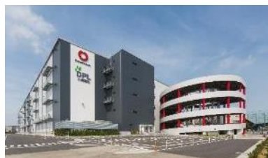
大型マルチテナント型物流施設「DPL川崎夜光」(神奈川県)
